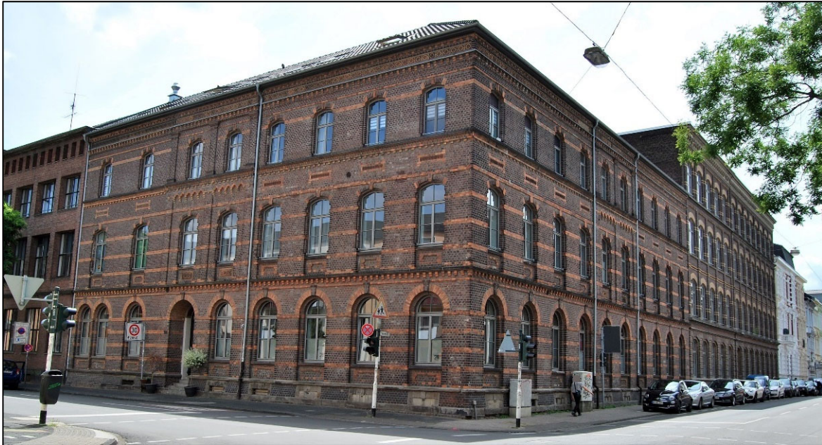
Abbildung 7: Denkmalgeschützter Teil der alten Samtweberei in Krefeld Quelle: Eigenes Foto (2020).
